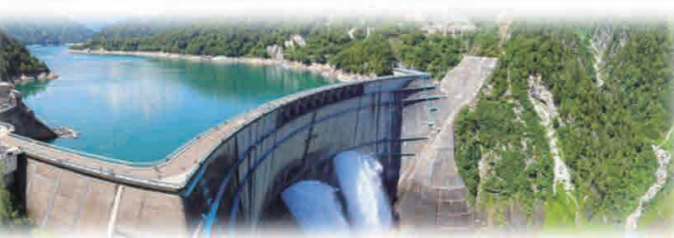
黒部ダム観光放水
